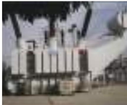
► **Imagen No 8:** Mantenimiento Mayor - Transformador de Reserva 100 MVA 220/66kV SIEMENS.
