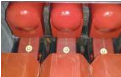
**Imagen No 11:** Recuperación Celda Circuito Tubocaribe por humedad.
