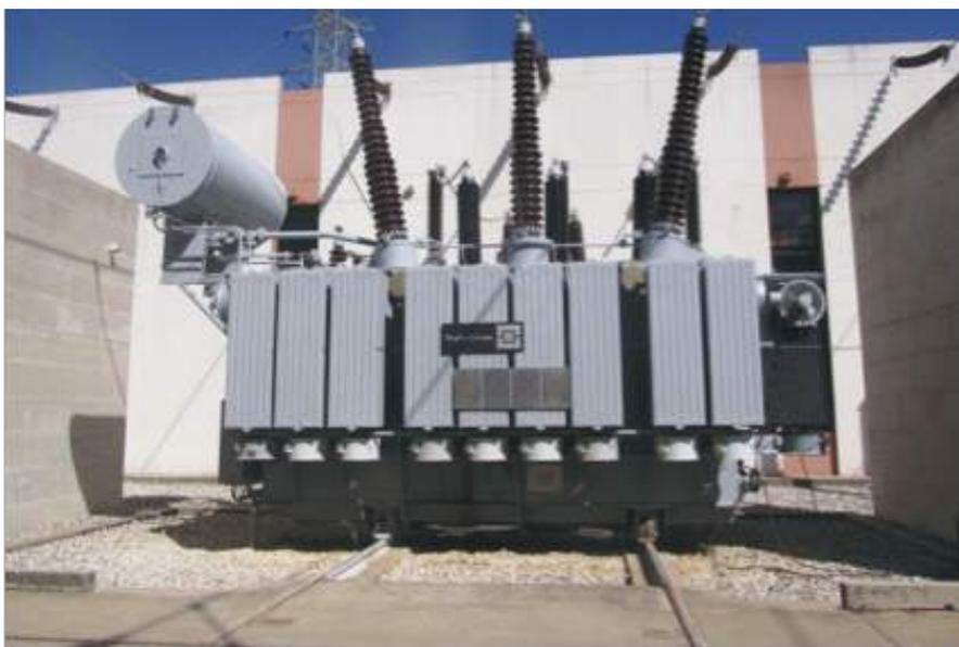
**Imagen No 3:** Atención Emergencia falla transformador CUESTECITAS 2 60 MVA 220/110/13.8 kV en subestación Cuestecitas
