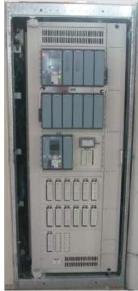
**Imagen No 17.** Cambio protección diferencial de barras Subestación Cuestecitas GIS 110KV.
