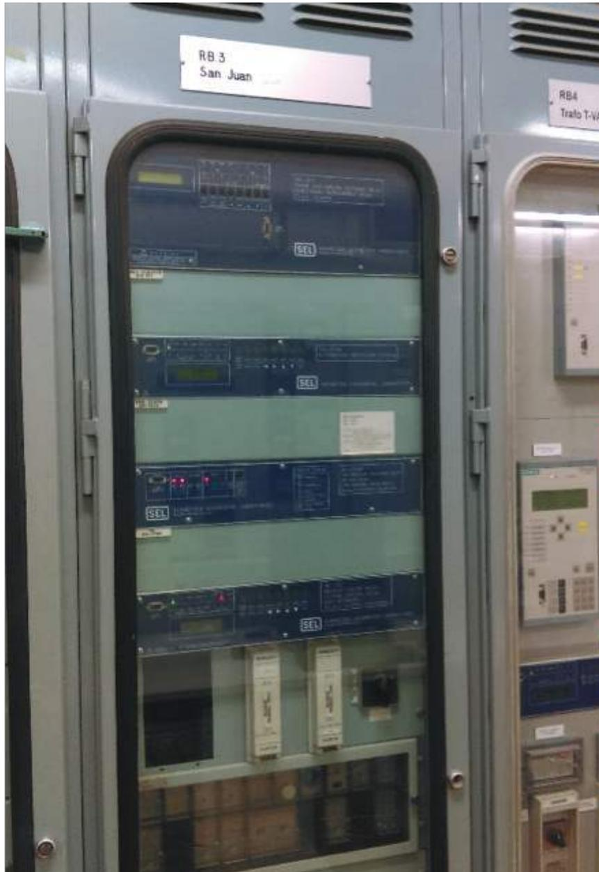
**Imagen No 5:** Cambio relés esquema de protección BL1
