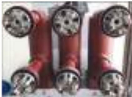
**Imagen No 10:** Recuperación Celda Circuito Tubocaribe por humedad.
