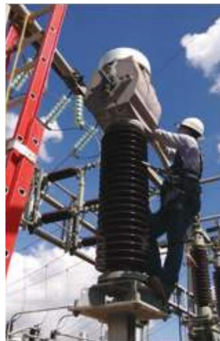
► **Imagen No 6:** Cambio y adaptaciones para montaje de nuevos Transformadores de Corriente.
