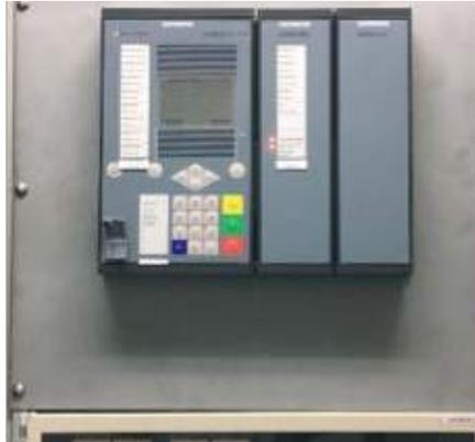
**Imagen No 9:** Renovación Esquema protecciones Bahía de línea 1 y 2 Temera a Termocandelaria 220 kV.
