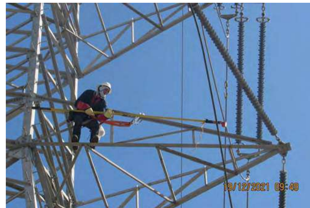
Ilustración 8 Actividades líneas Termocandelaria – Tenera 220kV 1 y 2
