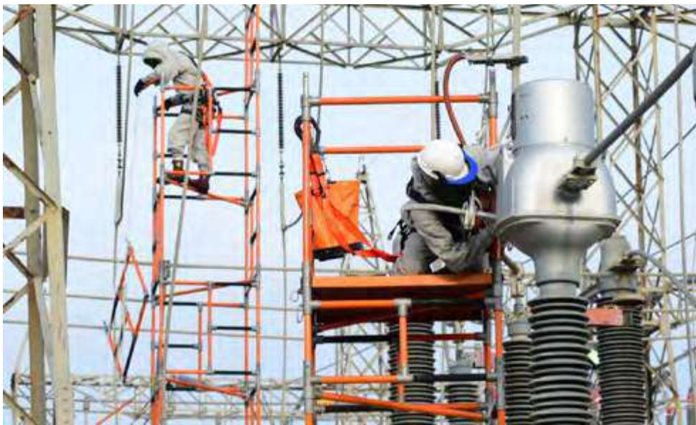
Ilustración 9 Trabajo con tensión
