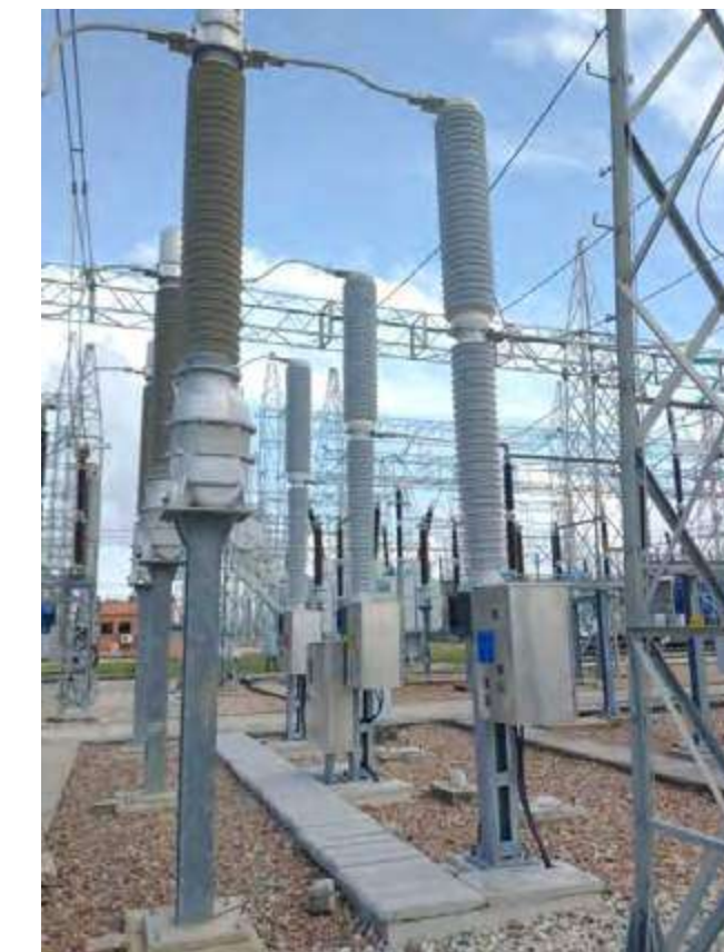
Ilustración 1 Interruptor polimérico de 40kA 220kV
