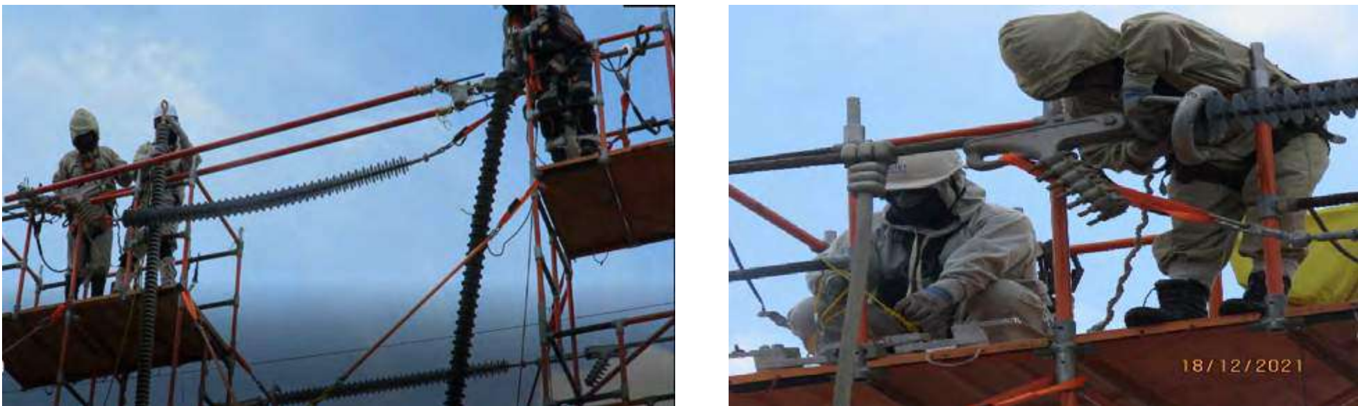
Ilustración 11 Trabajo realizado con tensión en VAL220 kV
