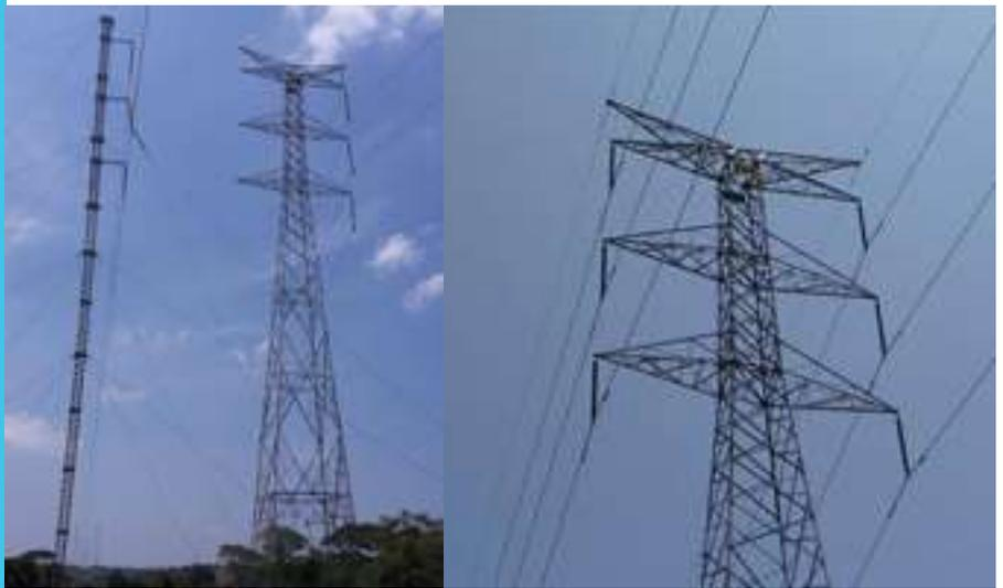
Imagen 14. Estructuras Derribadas (Torre 107 y 108) LIN 817/818 Imagen 15. Torre 109, Torre de Emergencia (izquierda) y Torre Definitiva Reparada (derecha) LIN 817/818
