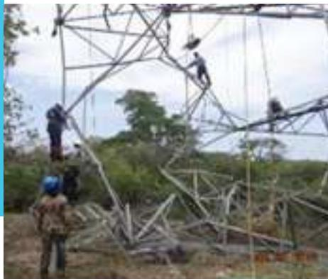
Imagen 11. Torre 96 Línea a 220kV Cuestecita – Valledupar 1. Antes de la reparación (izquierda) y después de la reparación (derecha).
