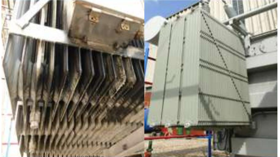
Imagen 2. Radiadores de Transformadores - Subestación Termoguajira
