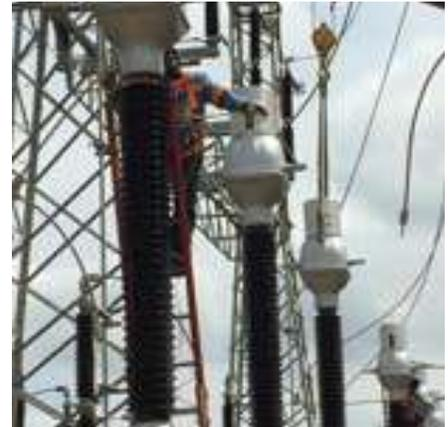
Imagen 4. Cambio de TC's Subestación Termoflores
