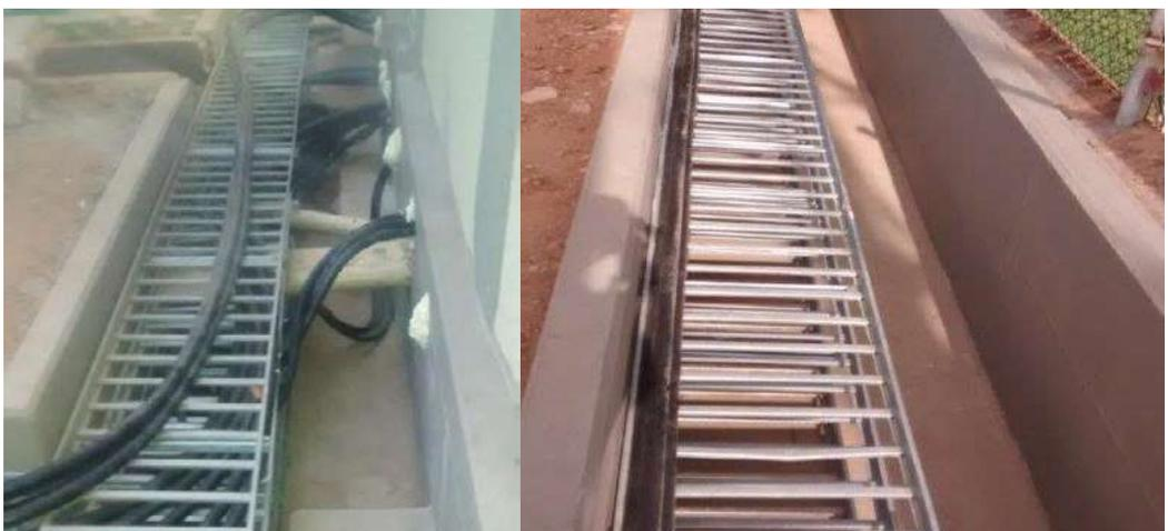
Imagen 20. Adecuación salida de circuitos a 13.8KV Subestación Valledupar.
