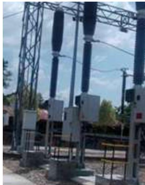
Imagen 7. Nuevo Interruptor COP 8100 – Subestación El Copey
