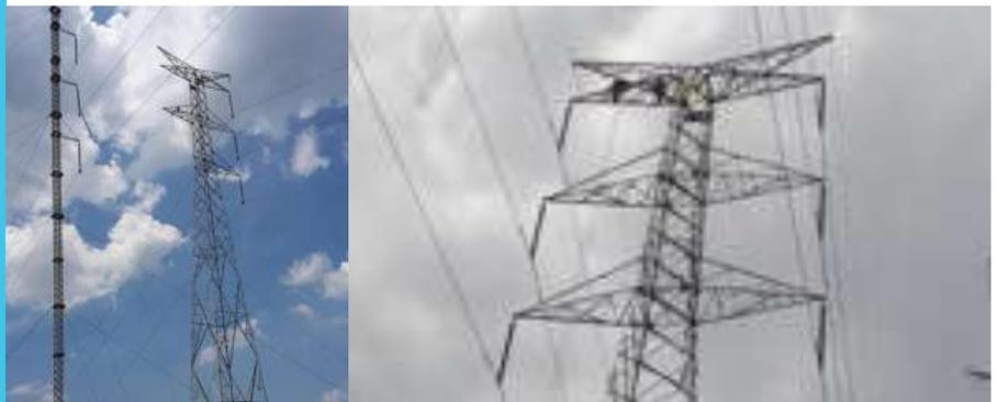
Imagen 15. Torre 109, Torre de Emergencia (izquierda) y Torre Definitiva Reparada (derecha) LIN 817/818
