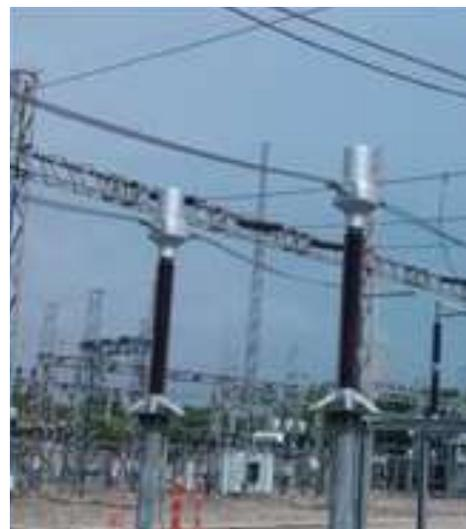
Imagen 9. Cambio de Transformadores de corriente QDR 220 kV
