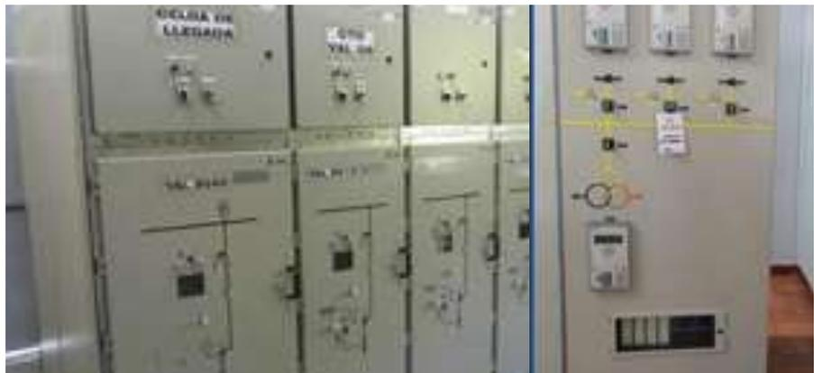
Imagen 5. Nuevo Tren de Celdas 13,8kV Asociadas a la Barra 1 Subestación Valledupar
