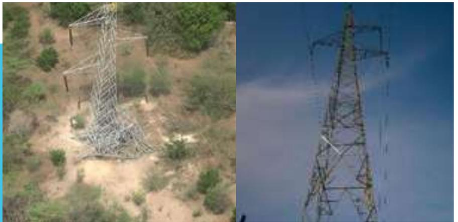
Imagen 10. Torre 63 Torre Línea a 220kV Cuestecita – Valledupar 1. Antes de la reparación (a la izquierda) y después de la reparación (a la derecha).
