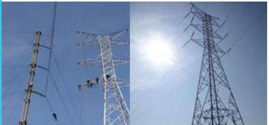
Imagen 17. Torre 111, Torre de Emergencia (izquierda) y Torre Definitiva Reparada (derecha) LIN 817/818
