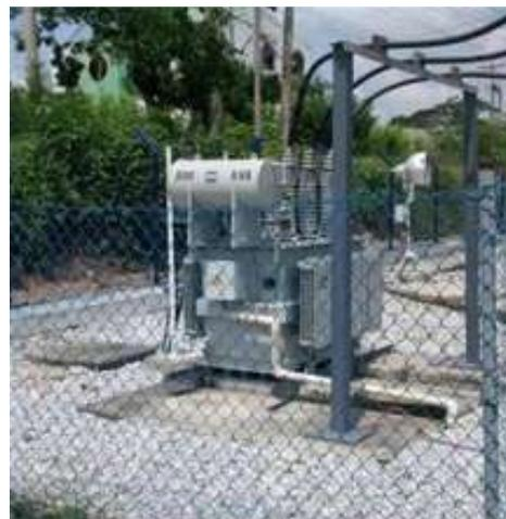
Imagen 8. Nuevo Transformador Auxiliares 34,5 / 13,8 kv Fundación
