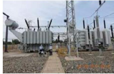
Ilustración 4. Puesta en Paralelo transformadores 220/110kV 100MVA en Valledupar.
