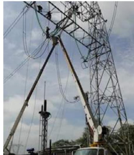
Figura No 8: Cambio aislamiento Subestación Sabanalarga 500 kV
