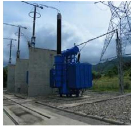
Figura No 7: Puesta en servicio reactor de línea fase A Subestación Copey 500
