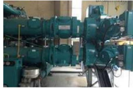
Ilustración 3. Ampliación Bahía Encapsulada SF6 145kV Subestación Termocartagena
