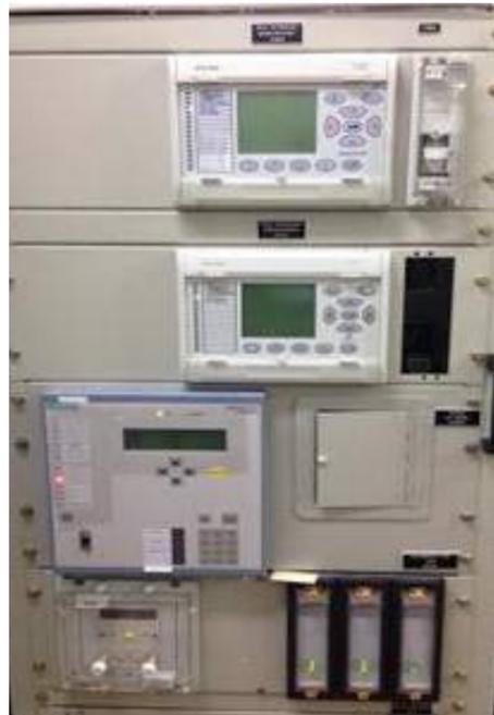
Figura No 4: Cambio de relés de protección Subestación Ternera
