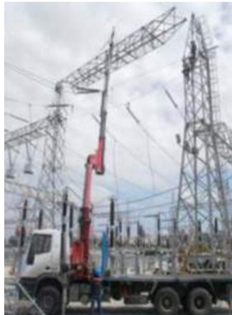
Figura No 3: Cambio de vigas pórticos Subestación Nueva Barranquilla
