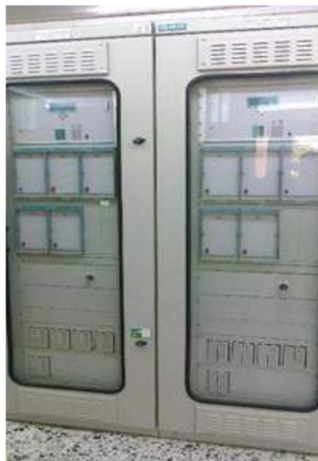
2. Se reemplazó la protección diferencial de barras 87B Termocartagena a 220 kV, por cumplimiento de su ciclo de vida y falta de soporte del fabricante.
