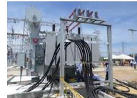
Ilustración 1. Conexión Ampliación Subestación Nueva Barranquilla 110/13,8kV - 45MVA.
