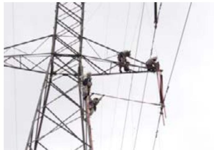
Figura No 12: Habilitación en Cambio de Cadenas en Suspensión y Retención con TCT
