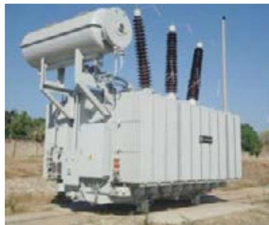
Figura No 7: Estado Final Transformador de Potencia de Reserva 220/34.5/13.8kV 45 MVA en Subestación Valledupar
