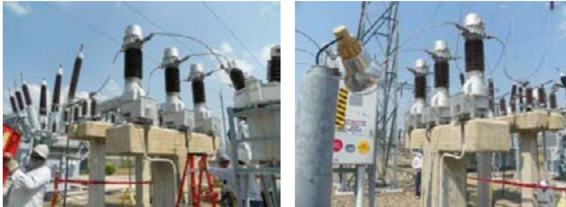
Figura No 6: Puesta en servicio nuevos transformadores de corriente subestación Copey
