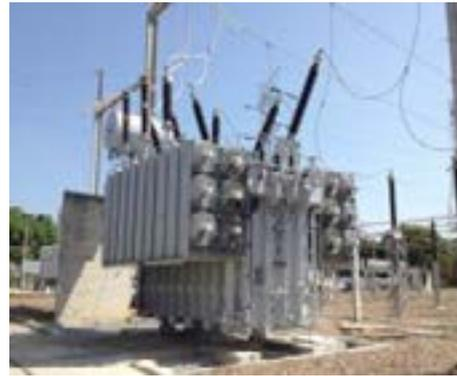
Figura No 17: Reposición de Transformadores 220/66kV 150MVA Subestación Ternera
