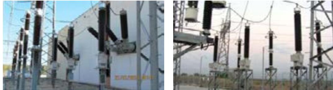
Figura No 8: Nuevos Transformadores de Voltaje 220kV Subestación Cuestecitas
