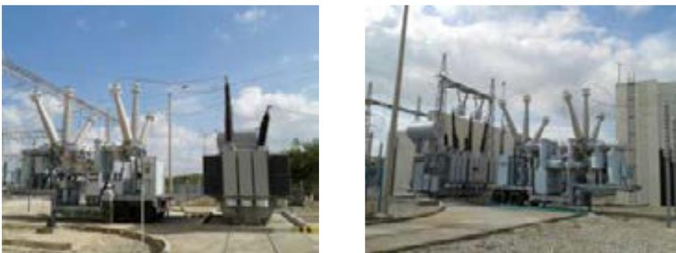
Figura No 19: Conexión Provisional 220/110kV Subestación Cuestecitas
