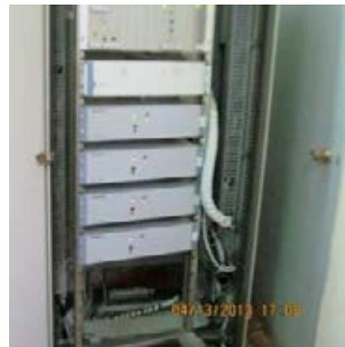
Figura No 13: Nuevos Equipos Terminales de Teleprotección Líneas de 220kV de TRANSELCA
