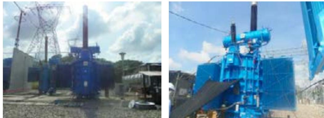
Figura No 15: Estado Final Reactor de Línea Copey a Ocaña 500kV
