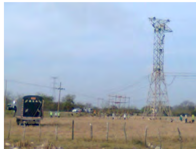
Figura No 10: Panorámica del cambio de superestructura en torre 111 de LN 827/828.
