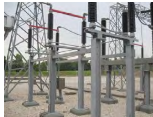
Figura No 15: Recuperación Subestación Nueva Barranquilla 110kV
