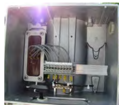
Figura No 7: Cambio transformadores de corriente en Subestacion Fundacion
