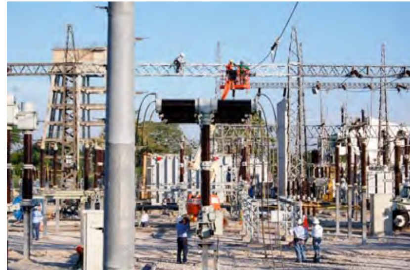
Figura No 9: Montaje nuevo Transformador de potencia instalado en la subestación Fundación
