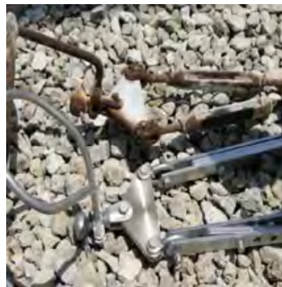
Figura No 5: Nuevos Herrajes en Acero Inoxidable Subestación Nueva Barranquilla
