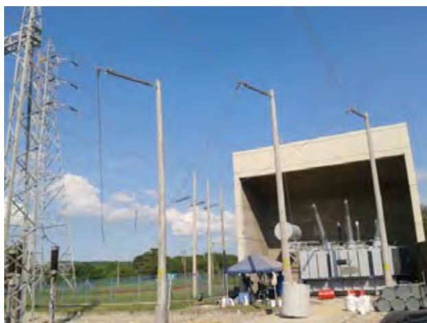
Figura No 12: Construcción de tramo en postería para conectar Barraje con Transformador durante Mantenimiento Encapsulado Cuestecita.
