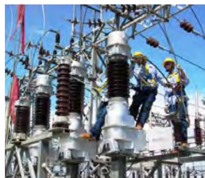
Figura No 7: Cambio transformadores de corriente en Subestacion Fundacion
