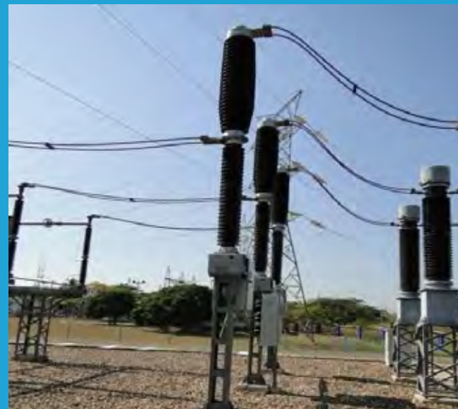
Figura No 3: Nuevo Interruptor de Potencia SAC-8710
