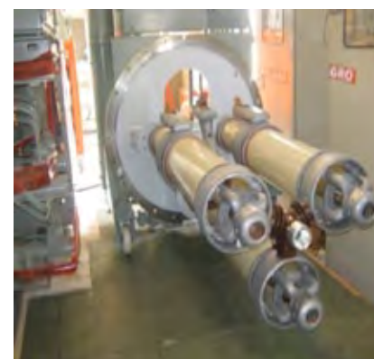
Figura No 6: Mantenimiento en subestación encapsulada Cuestecita 110 kV
